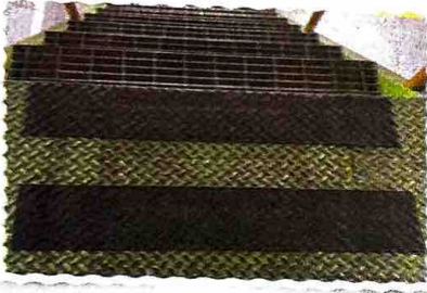
Merdivenlere kaydırmaz bant yapıştırılması
